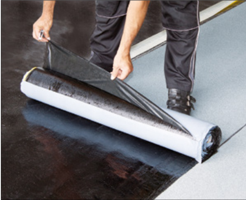
Bild 7: Verarbeitung von kaltselfstklebenden Polymerbitumenbahnen
