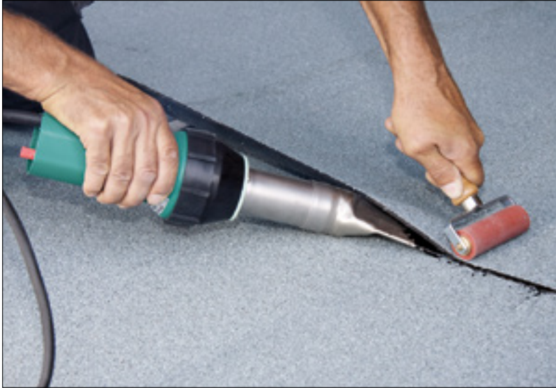
Bild 9: Fügen der Quernähte mit Heißluftfön und Andruckrolle
