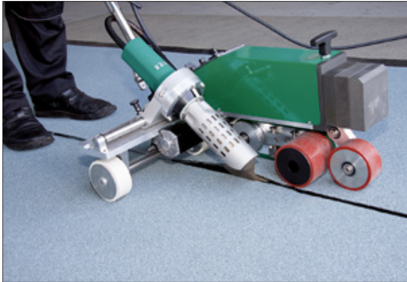
Bild 8: Schließen der Längsnähte mit dem Heißluftautomaten
