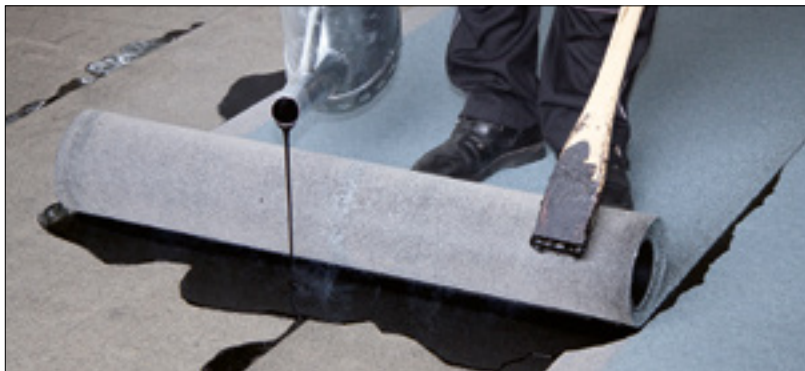
Bild 11: Verarbeitung einer Bitumenbahn im Gieß- und Einrollverfahren
