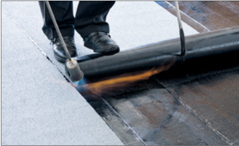
Bild 5: Aufbringen einer beschieferten Oberlagsbahn im Schweißverfahren
