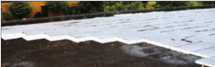
Bild 3: Beispiel einer Gefälledämmung aus Gefälledämmplatten
