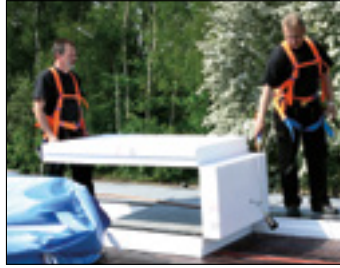
Bild 2: Verlegung einer kaschierten Dämmbahn
