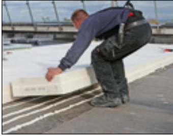
Bild 1: Verlegung von PU Dämmplatten
