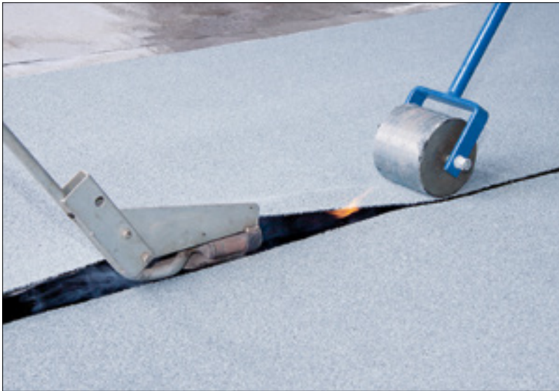
Bild 10: Verschließen der Längs- und Quernähte mit Nahtbrenner und Nahtabroller
