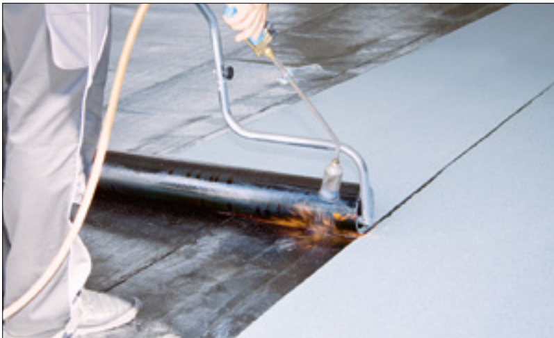
Bild 6: Verarbeitung im Schweißverfahren mit Rollenführungsbügel
