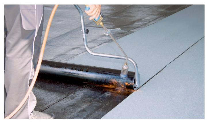
Beim Schweißverfahren wird zur Führung der Rolle ein Rollenzieher (oberes Bild) genutzt oder der Rollenführungsbügel (unteres Bild) zum Hinterherziehen der Bahn, bei dem das Laufen auf der noch warmen Bahn vermieden wird.
