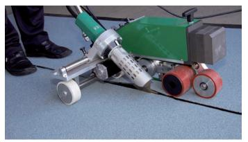
Bei der einlagigen Verlegung beträgt die Überdeckung mindestens 110 mm. Die Längsnähte werden mit dem Heißluftautomaten verschlossen, es ergibt sich ein gleichmäßiges Gesamtbild. Die Kopfnähte werden mit dem Heißluftfön und Andruckrolle verklebt.
