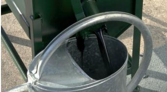
Bitumenmasse wird in einem Kocher erhitzt und zur Verarbeitung in eine Gießkanne gefüllt.
