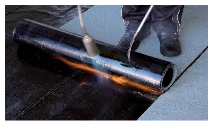
Wichtig ist die gleichmäßige Erwärmung der Bitumendeckschicht, so dass in ganzer Breite vor der Bahn permanent ein Bitumenwulst herläuft. Die seitlich austretende Bitumenmasse zeigt den optimalen, hohlraumfreien Nahtverschluss.
