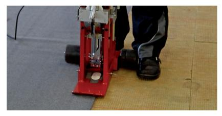
Bei der mehrlagigen Verlegung wird die erste Lage ausgerichtet und mit Befestigungselementen in den vorgegebenen Abständen befestigt. Die Befestigung erfolgt z.B. mit dem Setzautomaten im
