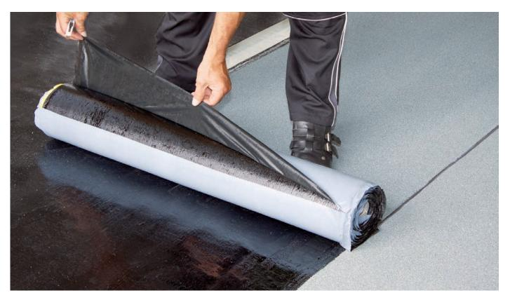
Nach dem Ausrichten der Bahn erfolgt der eigentliche Klebevorgang. Beim Entfernen der Schutzfolie wird die Bahn gleichmäßig angedrückt.
