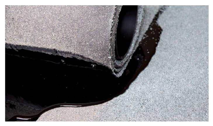
Wichtig ist, dass beim Gießen die heißflüssige Klebemasse so vor die aufzuklebende Bitumenbahn gegossen wird, dass beim Einrollen der Bahn ein Bitumenwulst in ganzer Breite vor der Bahn her läuft und seitlich austritt (wie oben).
