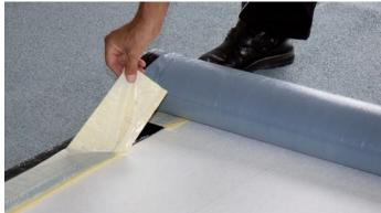
Das Kaltselbstklebeverfahren findet häufig Anwendung bei der ersten Lage der Abdichtung – als Unterlagsbahn direkt auf der Wärmedämmung. Aber auch Oberlagsbahnen können mit diesem Verfahren verarbeitet werden. Es ist besonders bei feuergefährdeten Unterkonstruktionen oder brandsensiblen Umgebungen geeignet.
