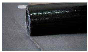
Die erste Lage bei der mehrlagigen Verlegung wird mit Befestigungselementen fixiert.
